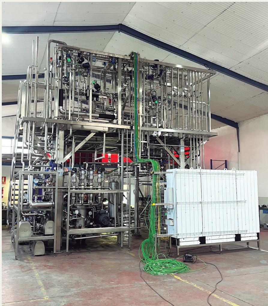
Imagen correspondiente a la fase de montaje en los talleres de Órbita Ingeniería para las pruebas FAT.
